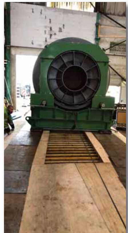
Mittels hydraulischem Zugsystem wird der Trommeltrockner behutsam verfahren.
