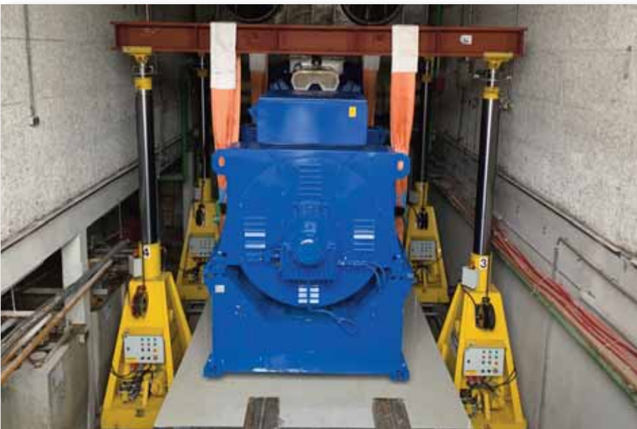
Es ist vollbracht - das BHKW hat den Aufstellort erreicht.
