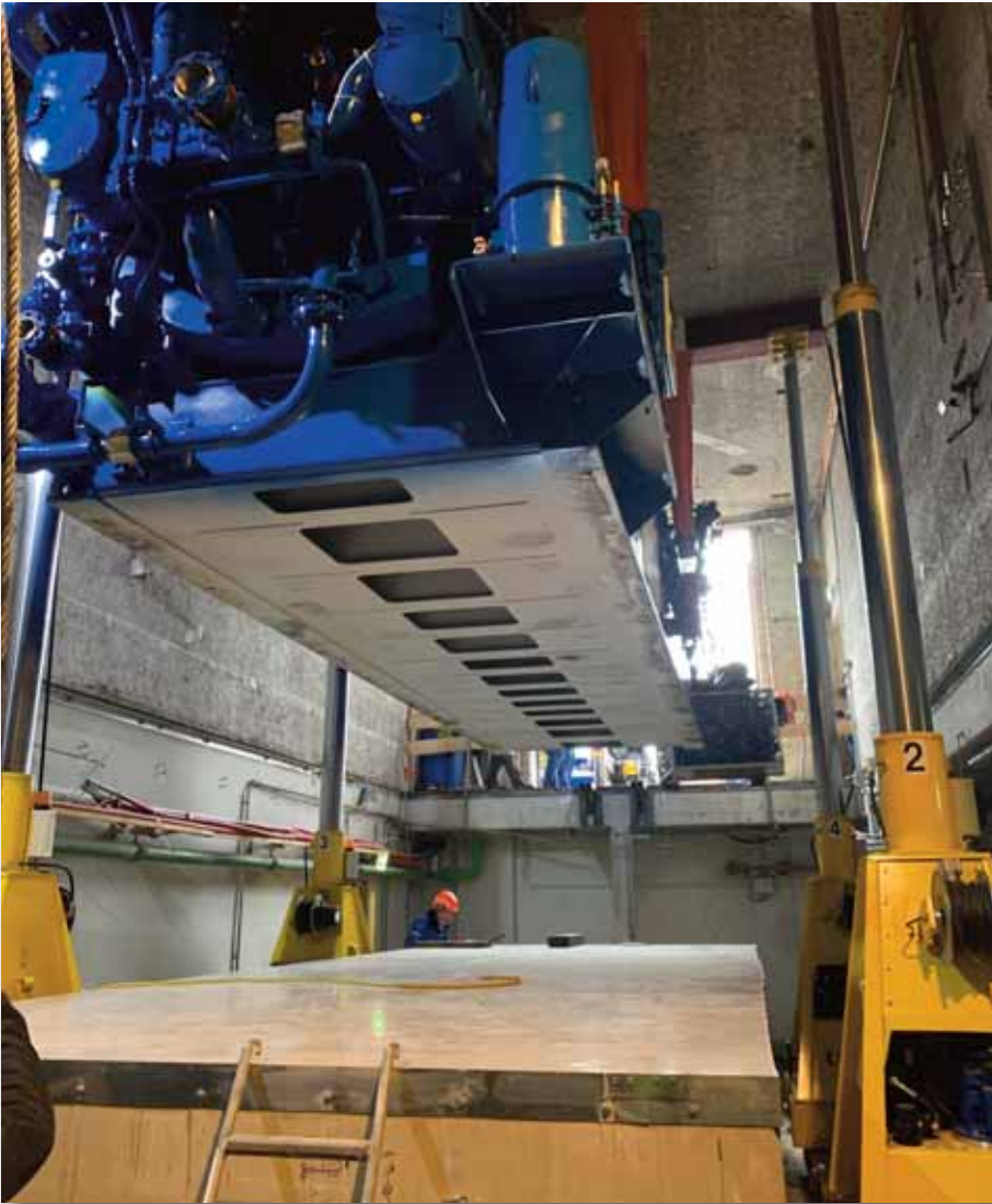
Nach der Demontage des Traglastgerüsts konnte das BHKW - am Hubgerüst hängend - abgesenkt werden.
