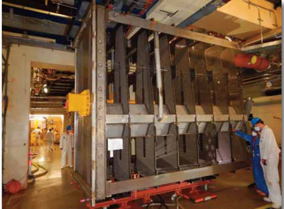
Verfahren eines Pakets mit einer auf Luftkissen stehenden Verfahreinrichtung.
