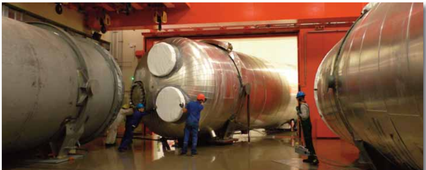
Throwback: Verschub einer von insgesamt vier gut 130to schweren Einheiten eines Wärmetauschers im Jahr 2017.
