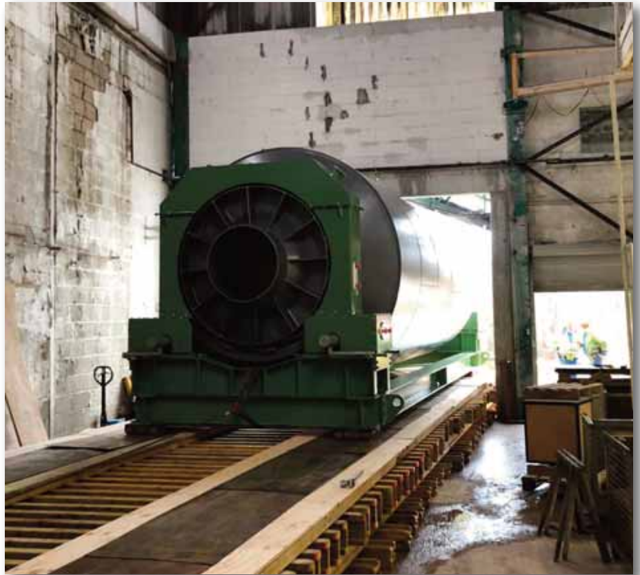
Mittels hydraulischem Zugsystem wird der Trommeltrockner behutsam verfahren.
