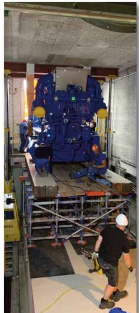
Einfahren des BHKWs auf das Traglastgerüst.
