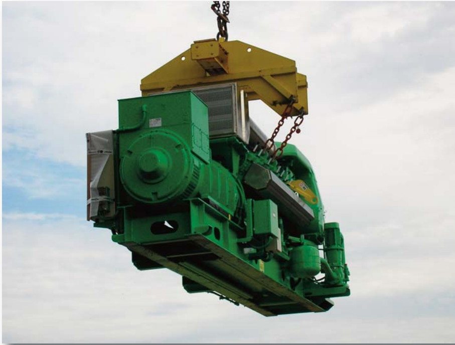
Das BHKW hängt am Haken und schwebt vor typischem Sylter Himmel der Tiefgarage entgegen
