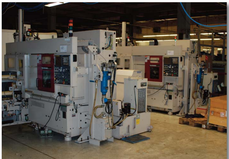
Zwei Bearbeitungszentren nach der Repositionierung - die Wiederinbetriebnahme folgte umgehend
