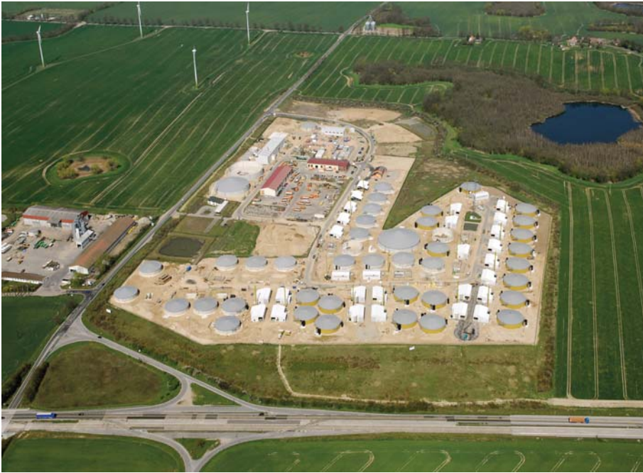
Der 20 MW-Biogaspark in Penkun (Mecklenburg-Vorpommern) besteht aus 40 Anlagen mit je 500 kW Leistung
