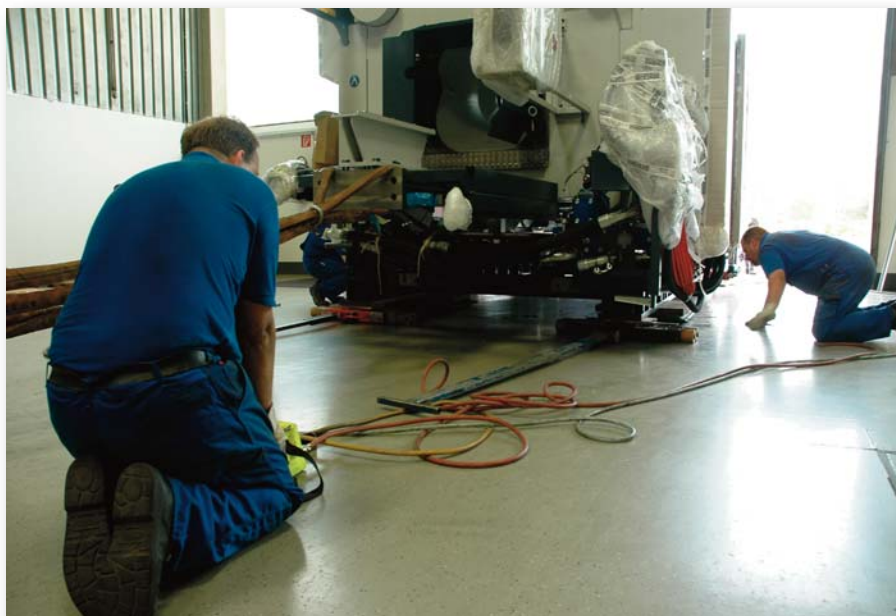
Mit Bedacht platzieren die VOLLMERT-Monteur Transportfahrwerke - mittels effizienter Hebekissentechnik
