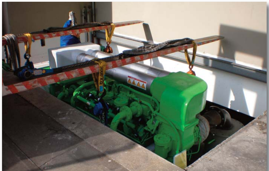
...wurden die neuen BHKW durch eine Öffnung in das Kellergeschoss gehoben,...
