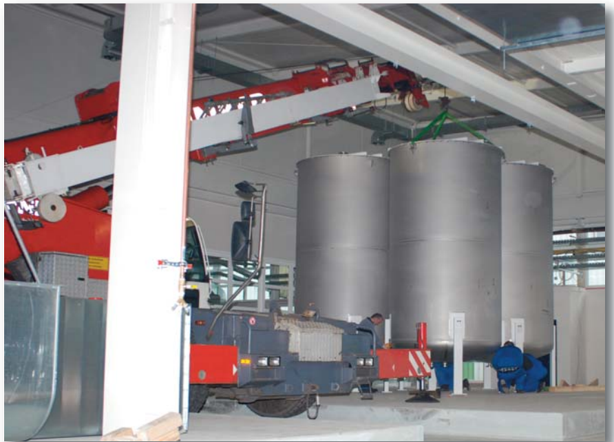
Perfektes Teamwork: die VOLLMERT - Montageprofis und der Spezialkran
