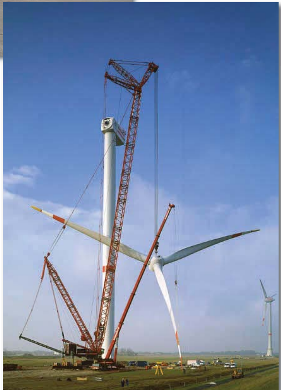
Liebherr Raupenkran LR 11350 bei der Montage einer Windkraftanlage.
