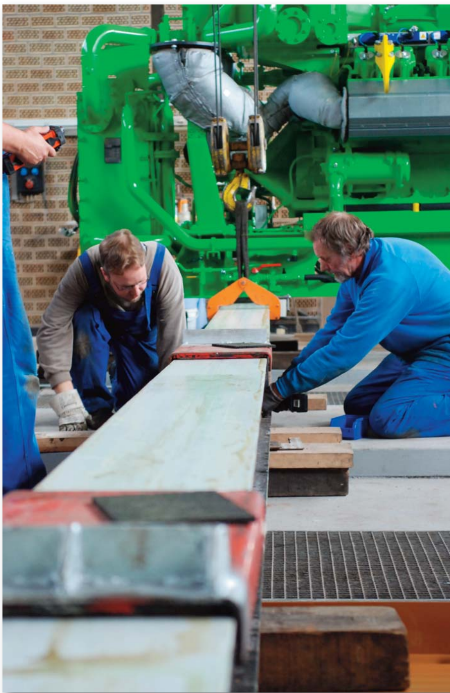
Das Ausrichten der Teflon®-Verschubbahn erfordert Präzision und Geduld.
